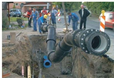
*Unterqueren eines Schmutzwasserrohres mit der Trinkwasserleitung*
